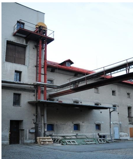
Obrázek 21: Příjmový koš a dopravníky na slad
