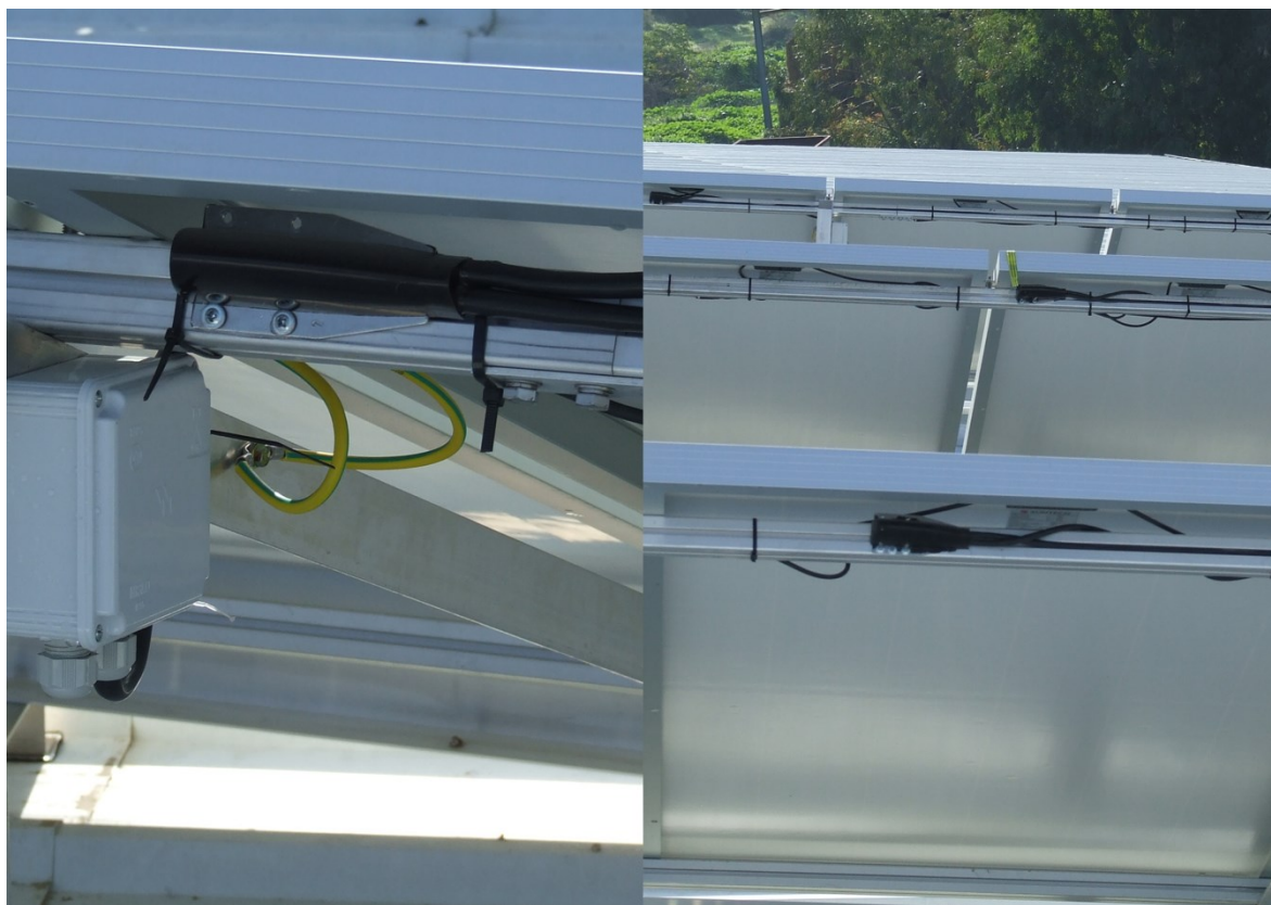
Obr. 22 Ochrana střešních FV panelů pomocí vibračních detektorů [Svoboda – vlastní]
