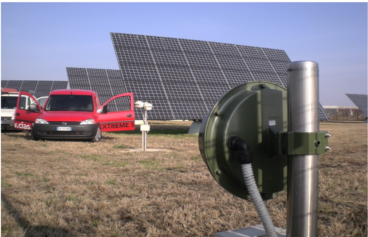
Obr. 18 Ochrana FVE pomocí digitální MW bariéry s analýzou [16]
