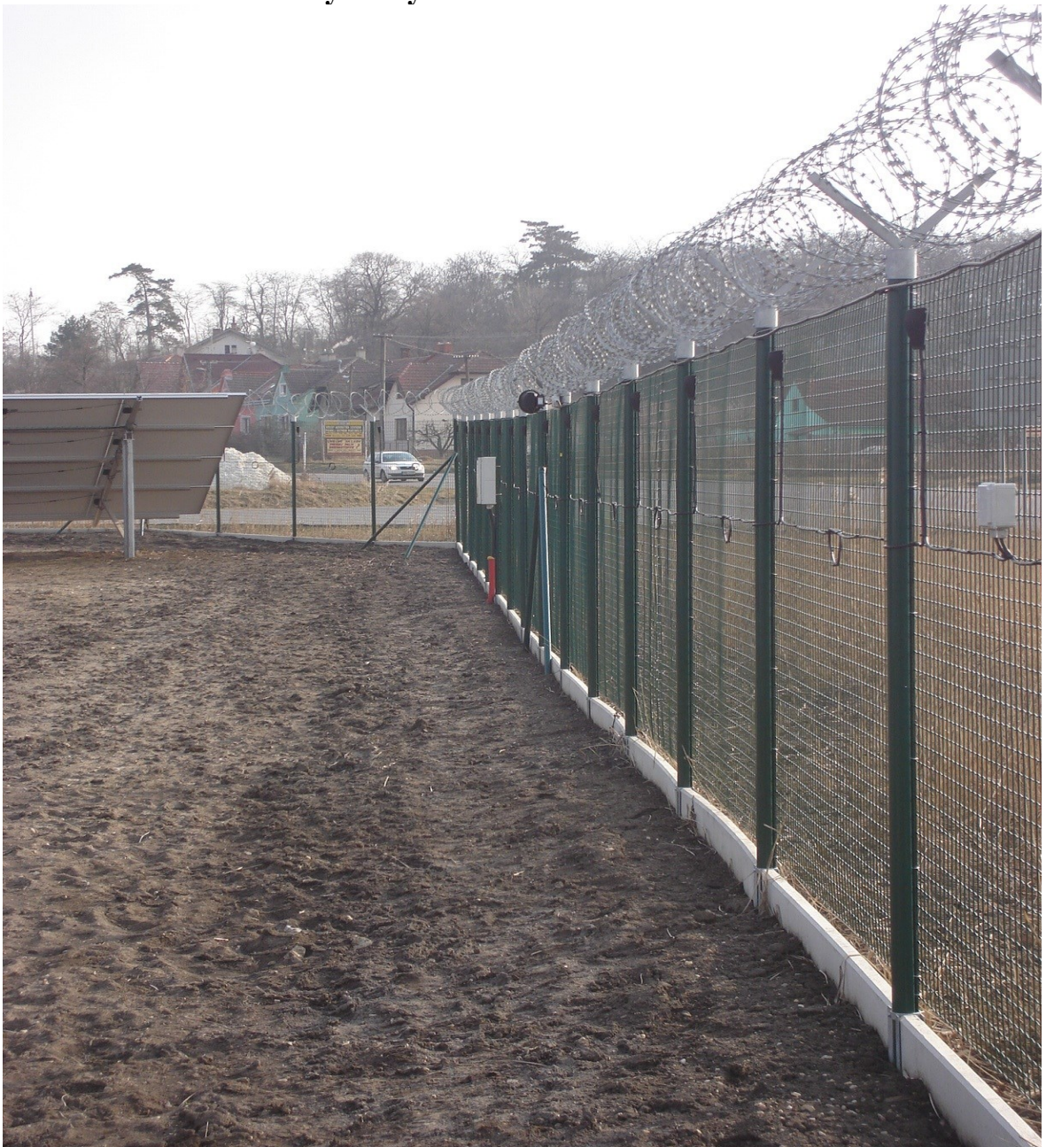
Obr. 16 Ochrana FVE pomocí plotového detekčního systému [Svoboda – vlastní]
