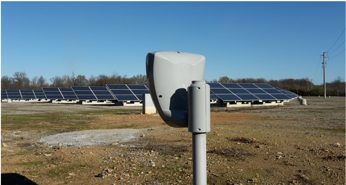
Obr. 17 Ochrana FVE pomocí digitální MW bariéry [15]
