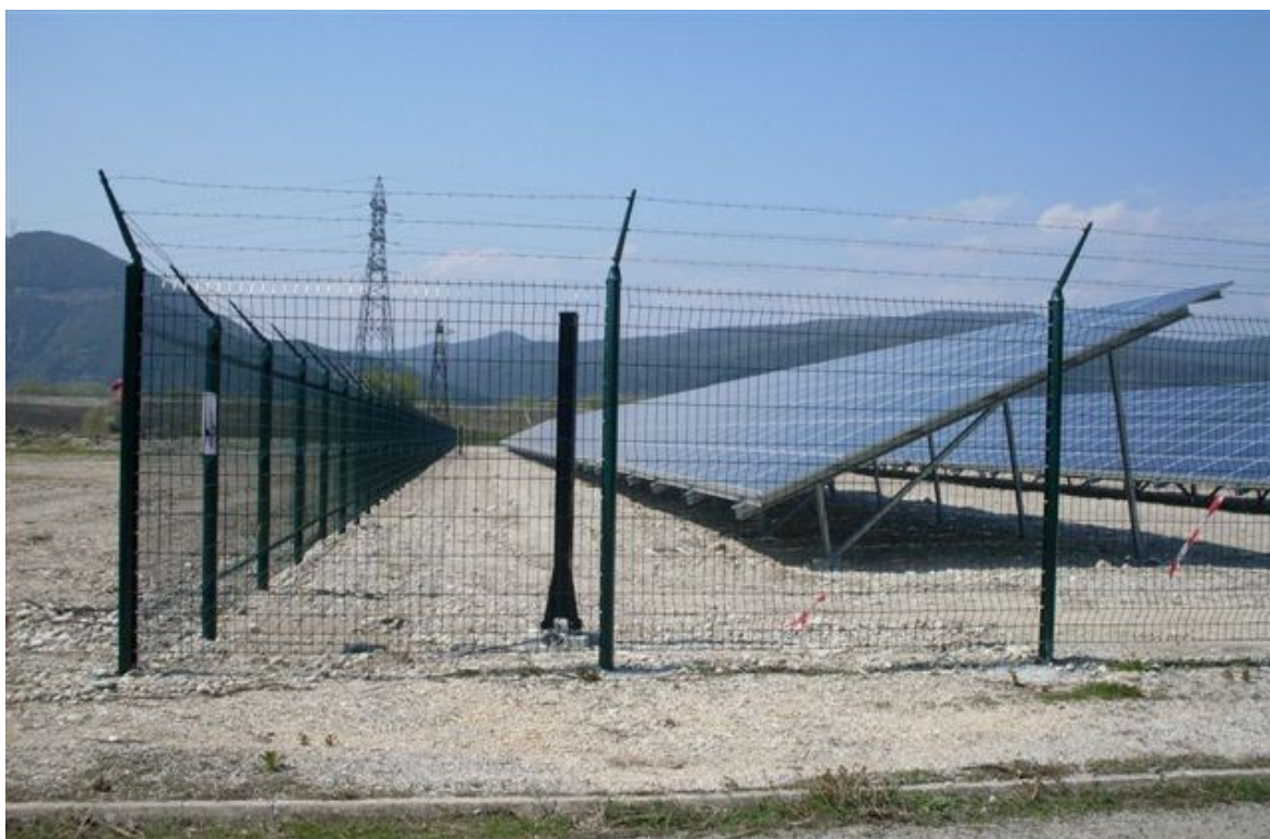
Obr. 15 Ochrana FVE pomocí MZS a IR bariér [14]
