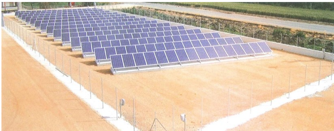
Obr. 20 Ochrana FVE pomocí kombinace MW bariér [18]
