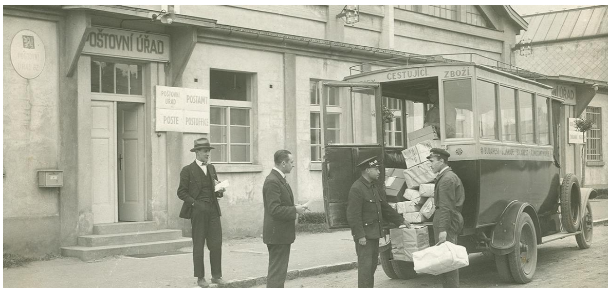
Obrázok 150 Historická fotografia označenie budovy pošty, zdroj: (Macková, ©2017).
