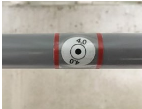
Obrázek 12: Ukázka redukce vzorkovacího bodu [13]
