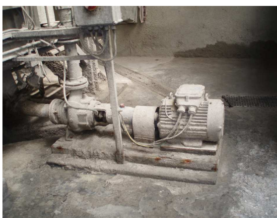
CEMBRIT – čerpání vody betonovou směsí
